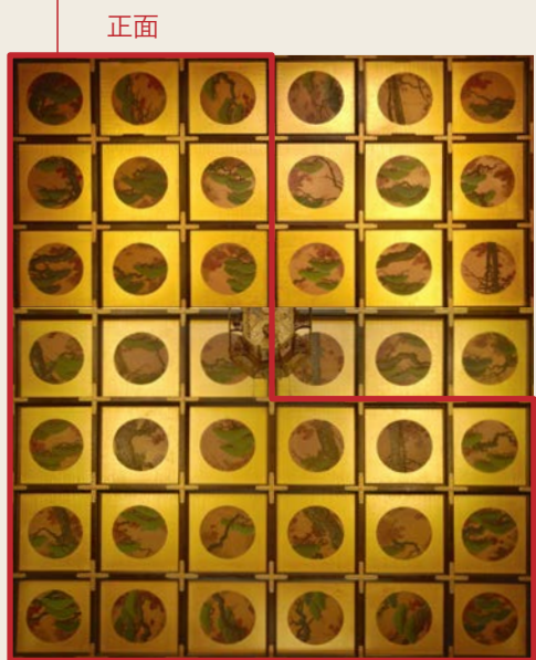
松楓の間天井(移設前)
