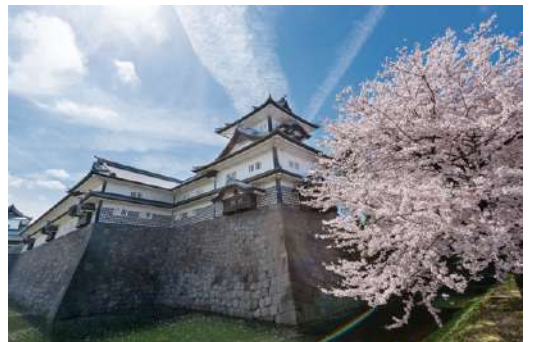
金沢城 復元された「菱櫓」「五十間長屋」 「橋爪門続櫓」の建物
