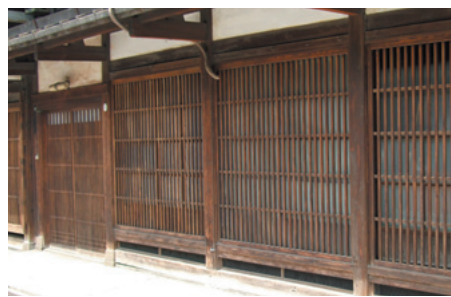
さまのこ さまのことは、高岡の方言で千本格子のこと。繊細な千本格子を作るには高い技術が必要で、光と風を取りこむ美しいさまのこの町並み風景はまさに日本の伝統的情緒と言える。
