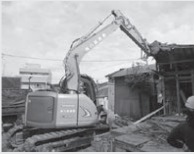
▲木造住宅の解体現場
