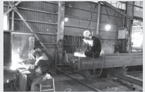
▲溶接作業中の様子(工場内)
