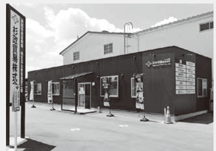
▲新展示場とともに新設した事務所
