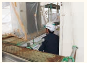
▲アスベスト除去作業の様子
